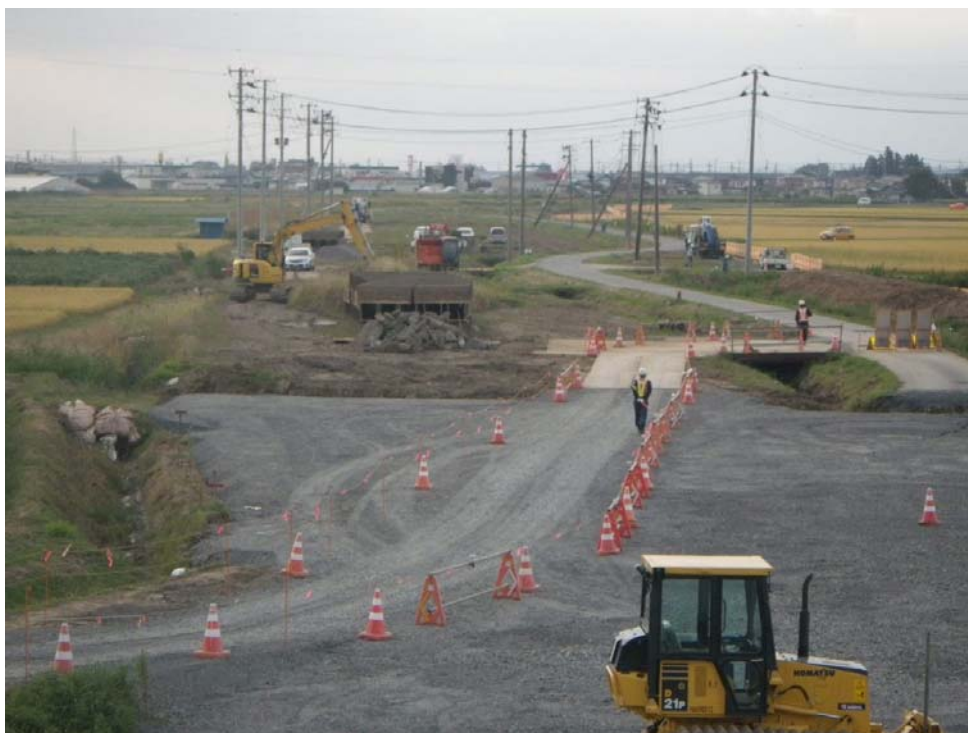
グラベルマット工実施状況（起点方向）
