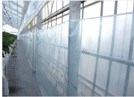
図 5-12 サイド周りはカーテンに加えて裾周りの被覆を設置すると夕方以降冷気の侵入を防ぐことができる
