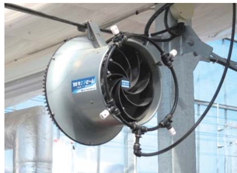
図5-9 細霧発生装置ノズルと循環扇のセット例
