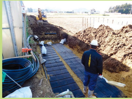
図4 地中熱ヒートポンプ交換器設置(深さ1m)
