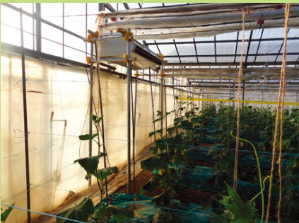
図6 地中熱ヒートポンプ室内機
