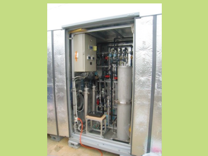
図14 逆浸透膜装置(岩沼市、日浄水量約25m 3 )
