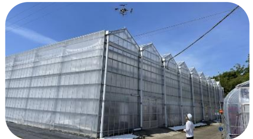
ドローンでの遮熱剤塗布によるハウスの温度昇温抑制効果の検証
