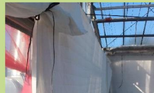
断熱資材を用いた暖房負荷軽減
