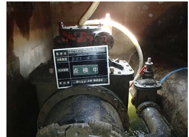
制水弁点検状況
