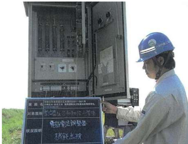
電気防食設備点検状況
