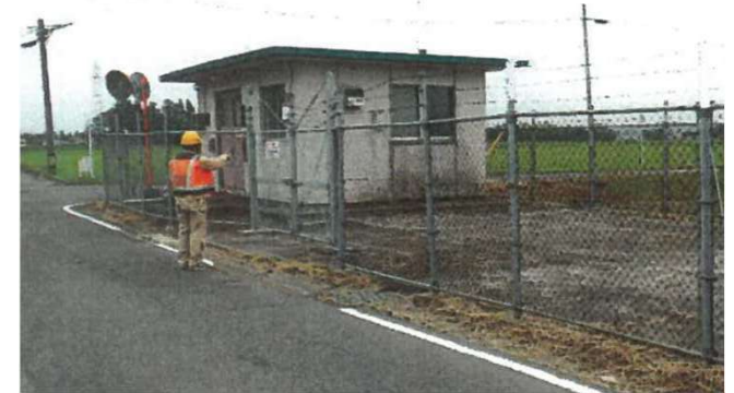
幹線テレメータ室の巡視状況
