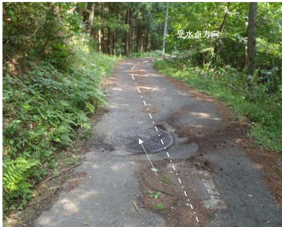
管理設区間の状況
