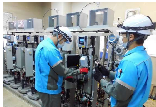
設備点検状況
