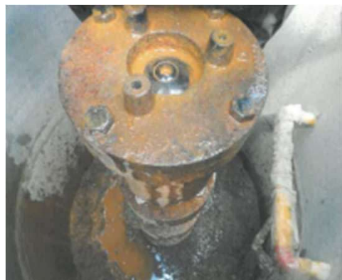
空気弁等の劣化や不具合状況(例)
