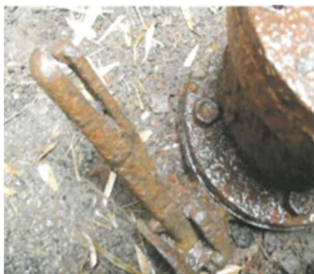
空気弁等の劣化や不具合状況(例)
