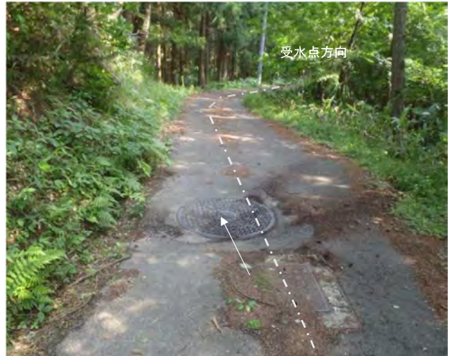
管理設区間の状況
