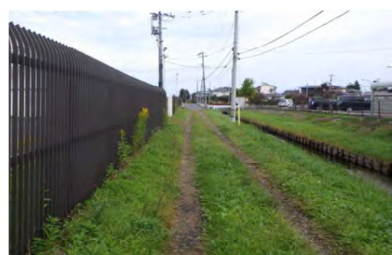
管埋設区間の状況
