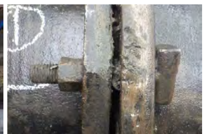
管継手部のボルト等の状況
