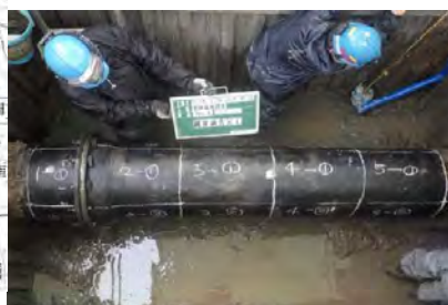
管体の腐食劣化調査の状況
