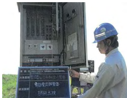
電気防食設備点検状況
