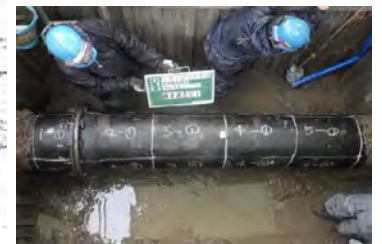
管体の腐食劣化調査の状況
