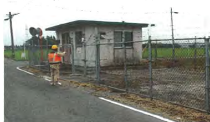
幹線テレメータ室の巡視状況
