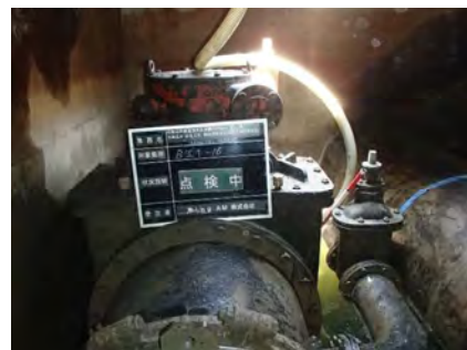
制水弁点検状況
