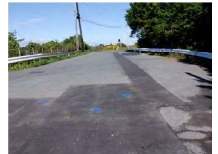
仮舗装の状況
