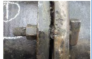
【管体調査のイメージ】 管継手部のボルト等の状況
