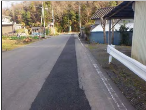
仮舗装状況(町道)
