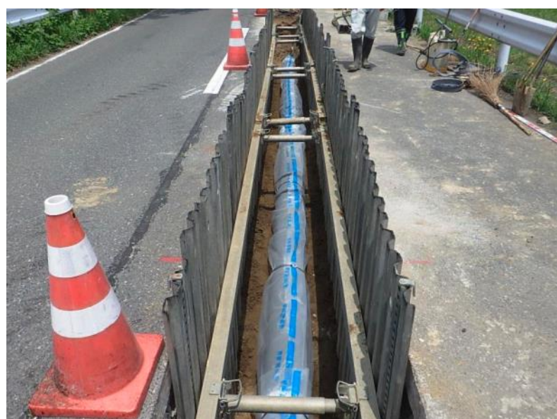
送水管布設状況
