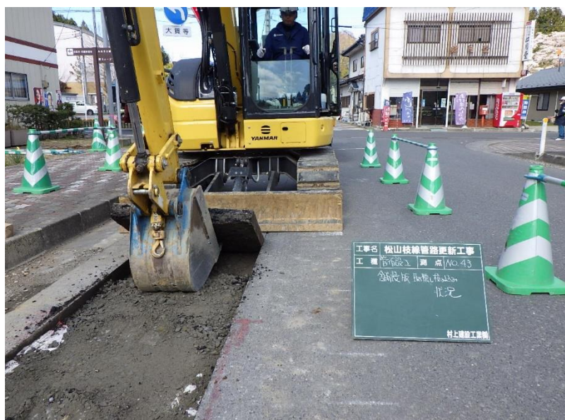
道路掘削状況
