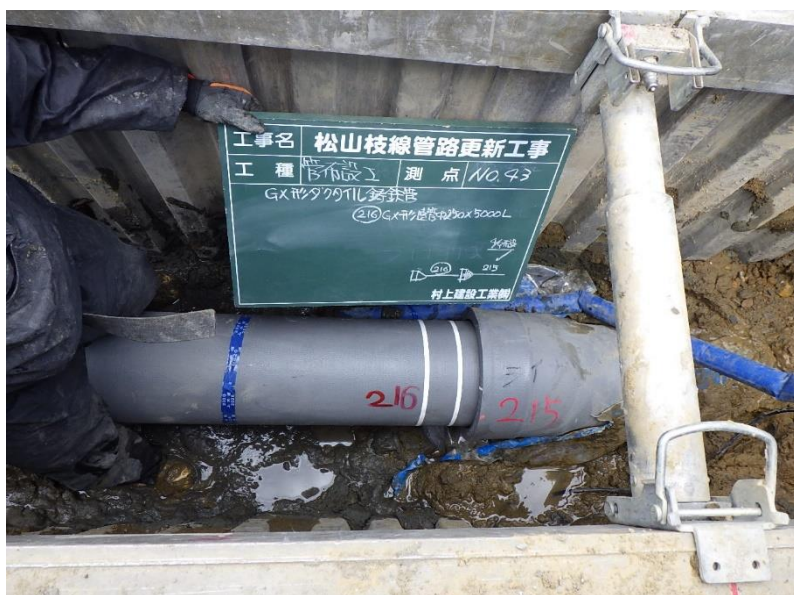
送水管布設状況
