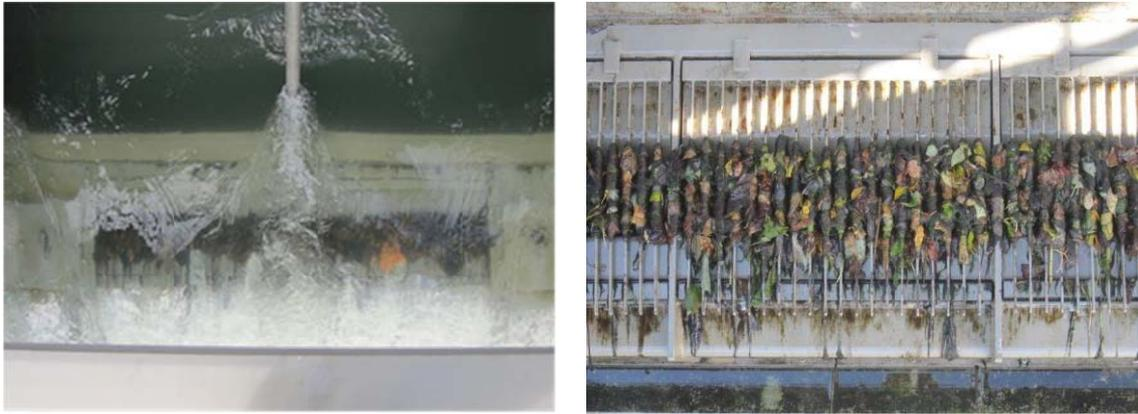
写真5, 6：水車本体取水口のスクリーンの目詰まり
