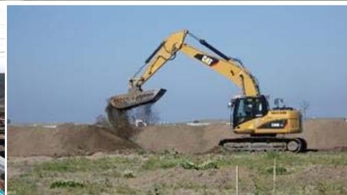
スケルトンバックホーによる雑物除去状況
