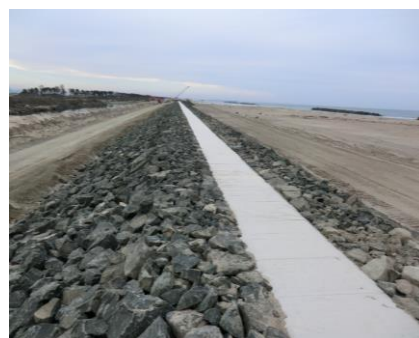
農地海岸の2次復旧完了(亘理町)
