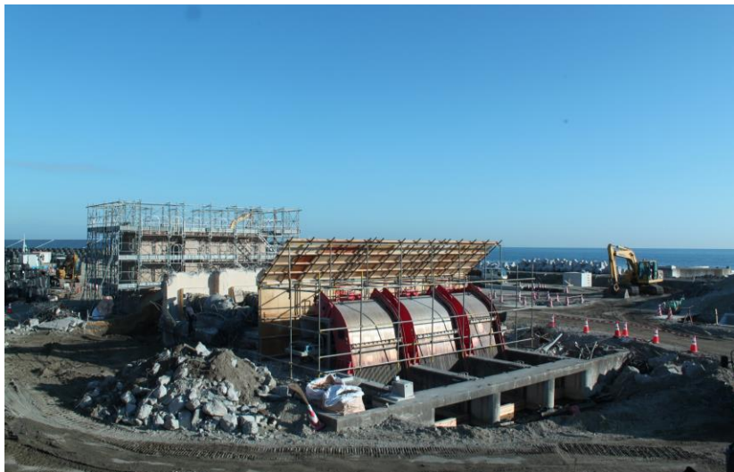
機場復旧工事（平成25年12月3日）
