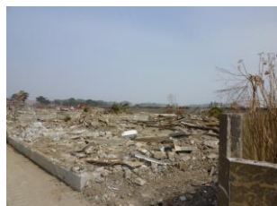
改良区事務所の流失
