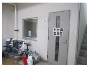
機場内に設けられた仮事務所
