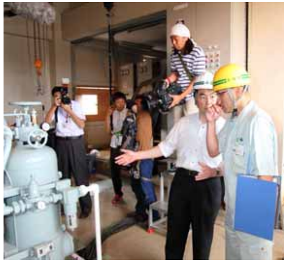
運転を開始した長面排水機場のポンプを 視察する村井知事（右から2番目）
