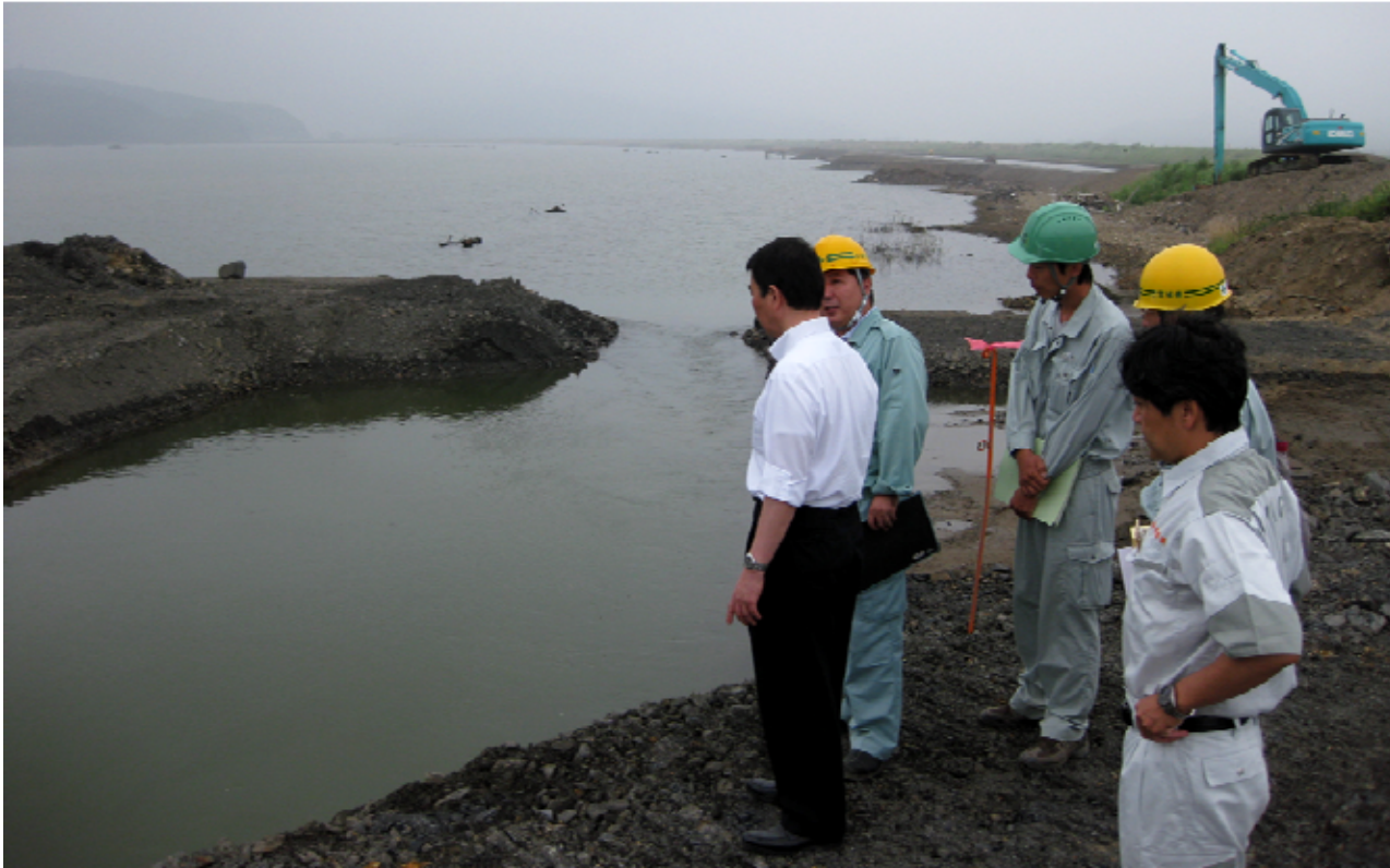
大川地区現場にて東部地方振興事務所担当者（左から2番目）から説明を受ける村井知事（左） =8月3日 石巻市
