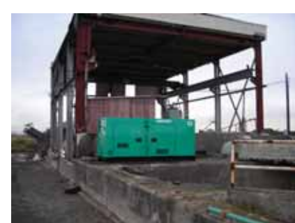
大堀排水機場の仮復旧(仙台市)
