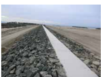
農地海岸の2次復旧完了(巨理町)
