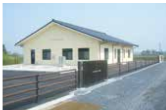
農業集落排水事業 長谷地区(登米市)
