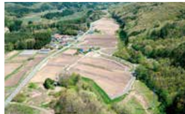
県営中山間地域総合整備事業 七ヶ宿2期地区(大原工区)
