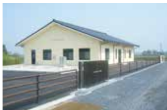
農業集落排水事業 長谷地区(登米市)
