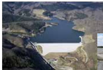
上:国営鳴瀬川地区 (加美町・二ツ石ダム)
