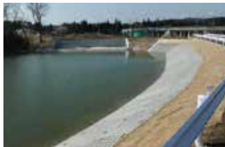
ため池等整備事業 勝負沢地区(大和町)
