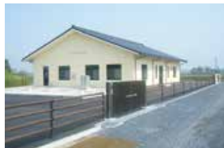
農業集落排水事業 長谷地区(登米市)
