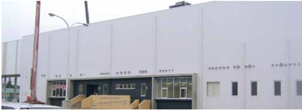
写真 完成した仙台市中央卸売市場食肉市場（小動物解体室）
