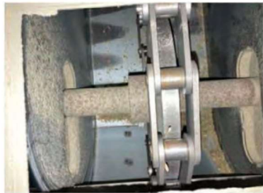
③投入チェーンコンベア 頭部コンベア底 頭部点検口を開けて清掃
