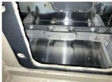
⑤排出チェーンコンベア 尾部側コンベア底 尾部点検口を開けて清掃
