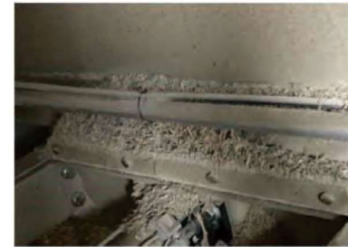
④丸ビン 投入コンベア周辺 点検扉を開けて清掃
