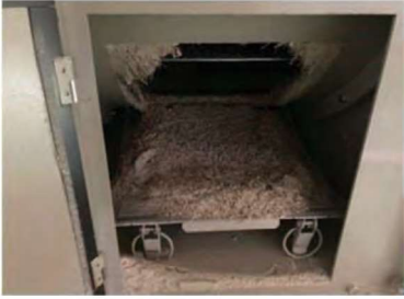
①昇降機 下部ブーツ底 下部カバーを開けて清掃
