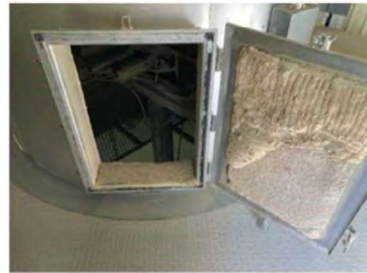
④丸ビン 上部点検扉周辺 点検扉を開けて清掃
