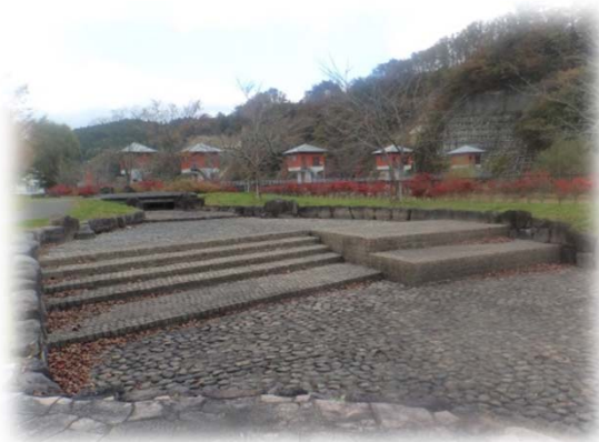
ミニチュア版の旧伊豆野堰 (古くから地域の人々に親しまれた施設を後世に残すため 作られました。奥に見えるのが、現在の伊豆野頭首工です。)
