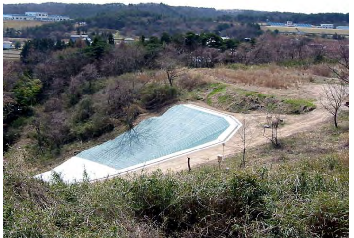
▲館下地区(地すべり対策)
