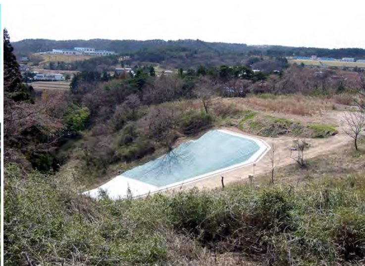
館下地区(地すべり対策)
