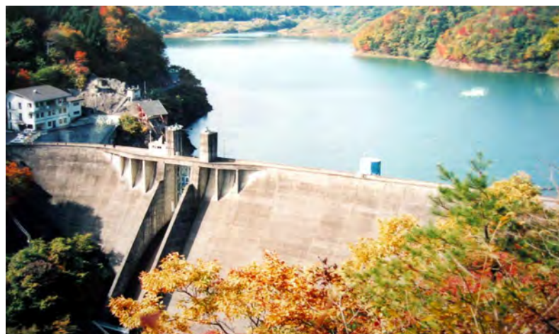
玉山地区(農業水利施設保全対策)・・・事業の対象となっている栗駒ダム
