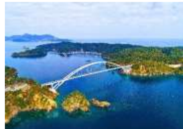
出島大橋の開通 (R6.12.19 女川町)
