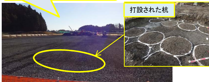
写真② 地盤改良完了後の様子
