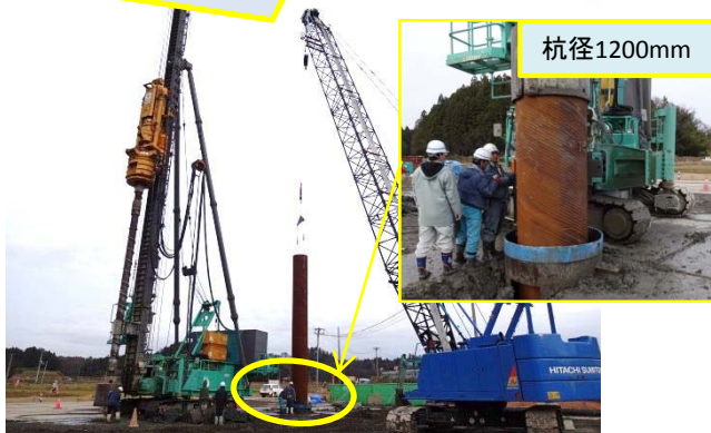
写真③ 基礎杭(鋼管ソイルセメント杭)打設の様子
