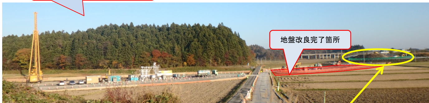
⑥(仮称)萩沢本線橋下部工工事の様子
