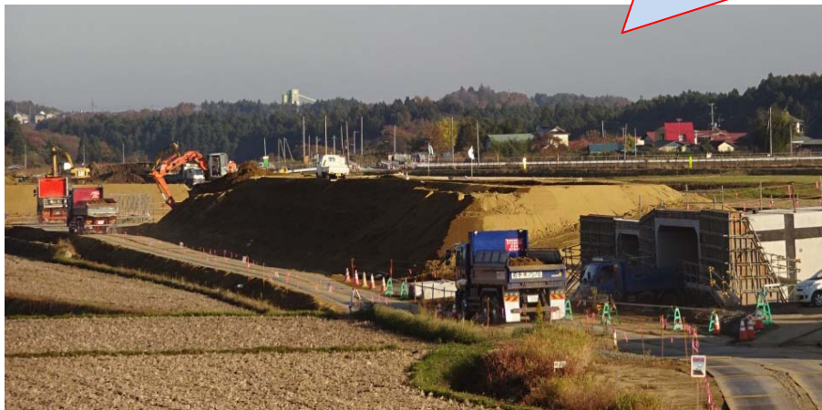
写真(3) ①②工事の様子
