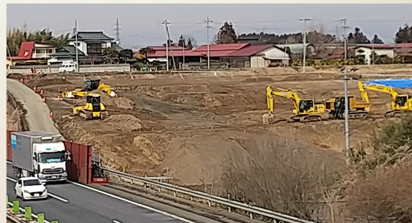
作業ヤード造成工(令和6年3月8日撮影)
