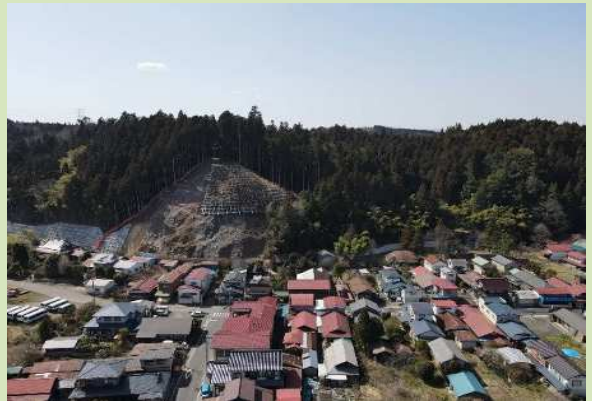
川口急傾斜地崩壊対策事業【継続中】
