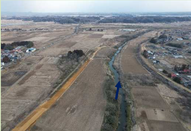
一級河川迫川（築館工区）河川改修事業【継続中】
