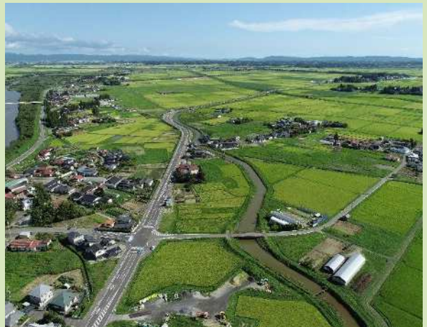
一般県道若柳築館線 川南道路改良事業【完成】
