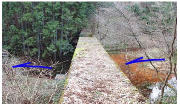
写真-3.1.2 P2 堰堤堆砂状況
