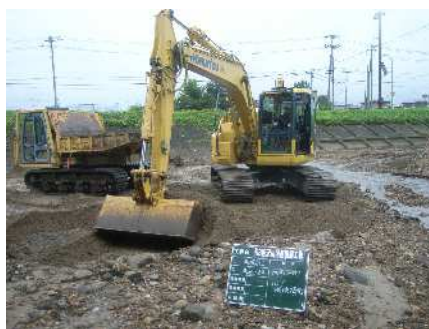
堆積土砂撤去
