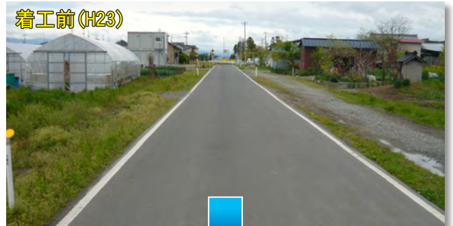
施工状況(H27)
