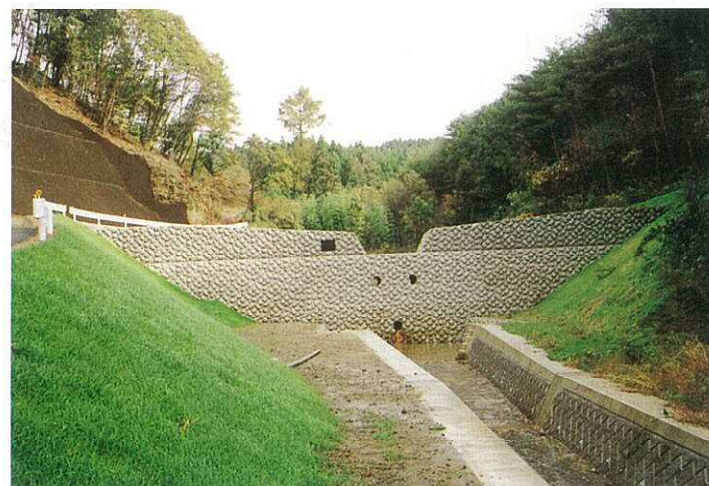
宿の沢砂防ダム（H7完成）
