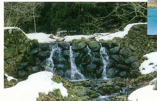
保存されている玉石積堰堤（現在）
