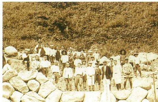
館の沢砂防堰堤工事（大正15年当時）
