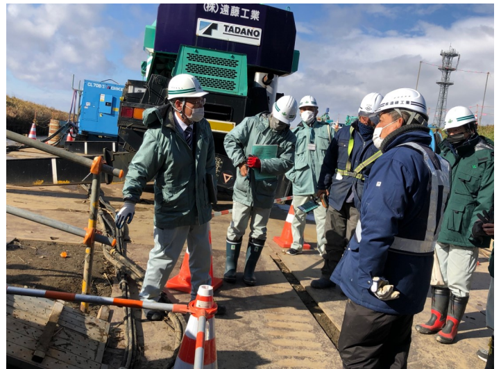
現場研修状況
