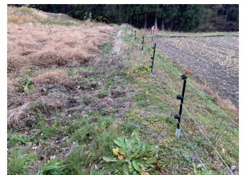
外側だけ掘られている電気柵
