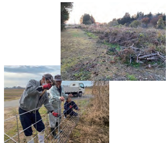
設置作業の様子
