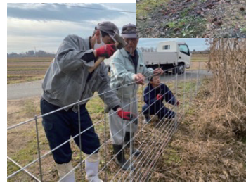
設置作業の様子
