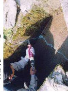
水路のひび割れ補修
