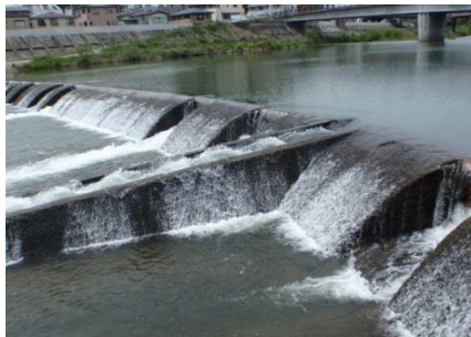
写真2 愛宕堰の魚道。流速が2m/秒近くあり、多くのアユは遡上できない可能性があります。
