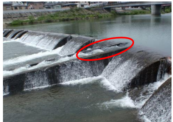
図7 愛宕堰の流速測定箇所 (赤丸内)
