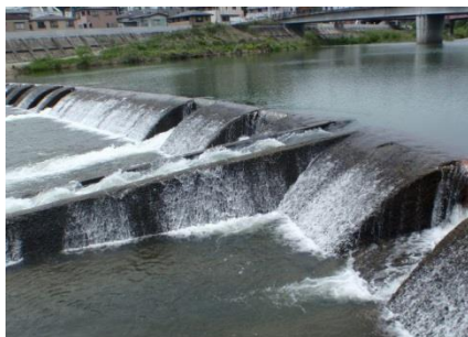
写真2 愛宕堰の魚道。流速が2m/秒近くあり、多くのアユは遡上できない可能性があります。
