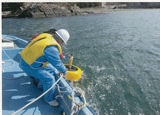
図1 水温ブイ設置作業(石巻市佐須ノ浜)
