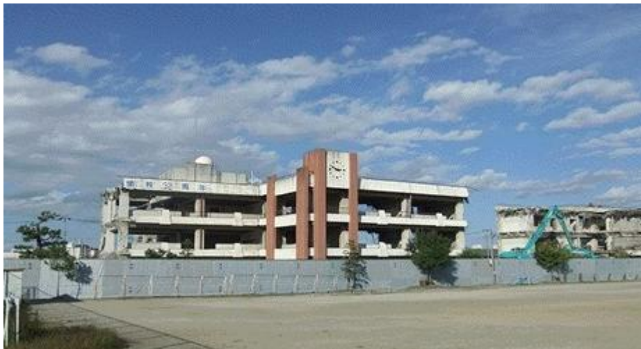
古川東中学校・鉄筋校舎の解体工事(平成23年10月)
