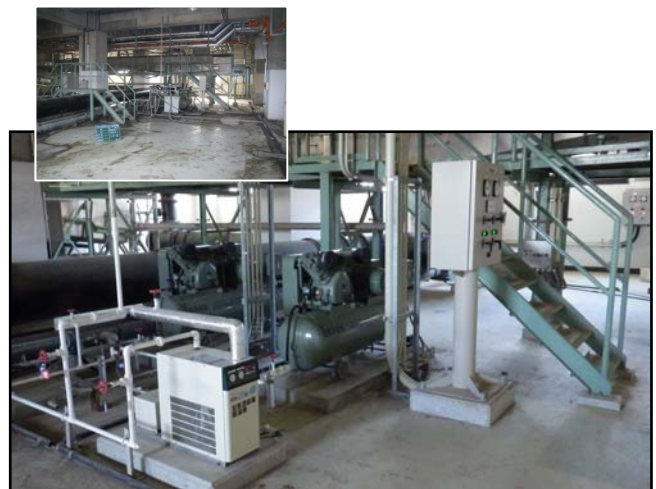
復旧状況（瓦礫撤去・空気圧縮機・ベルトコンベア）
