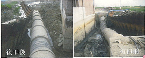
放流管の復旧
