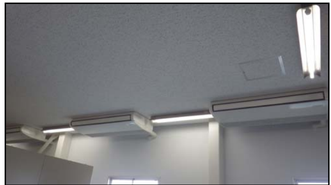
復旧状況（空調機）
