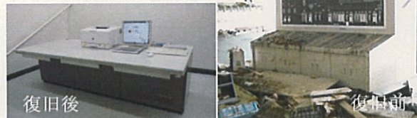
監視装置の復旧 (1階から2階へ移動)
