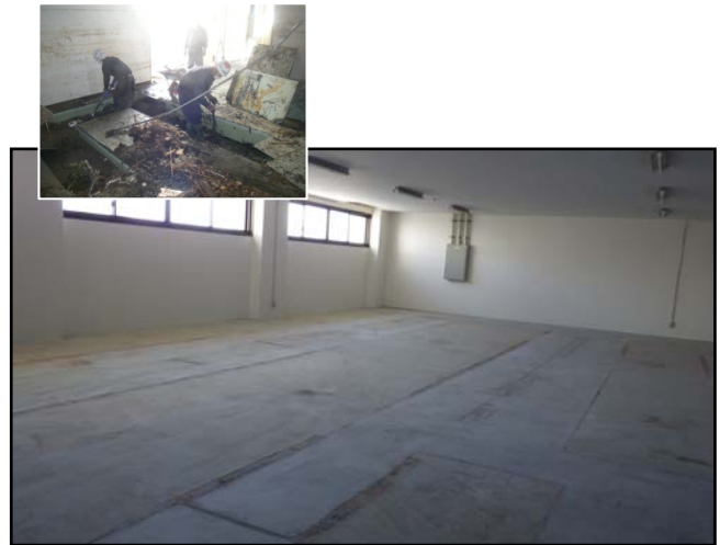
復旧状況 (瓦礫撤去・電気室を2階へ移設)
