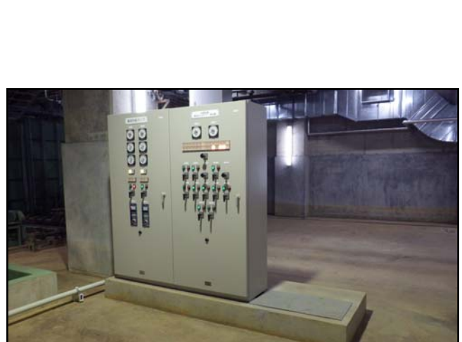
復旧状況（瓦礫撤去・現場盤）
