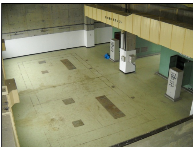
施工前状況 (2階津波浸水なし)
