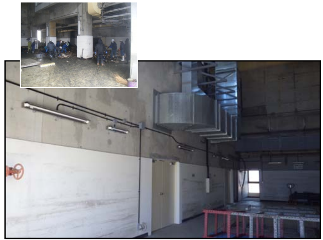
復旧状況（瓦礫撤去・換気ダクト・照明器具）
