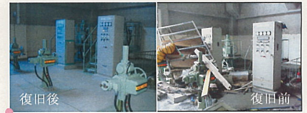
汚水ポンプの復旧
