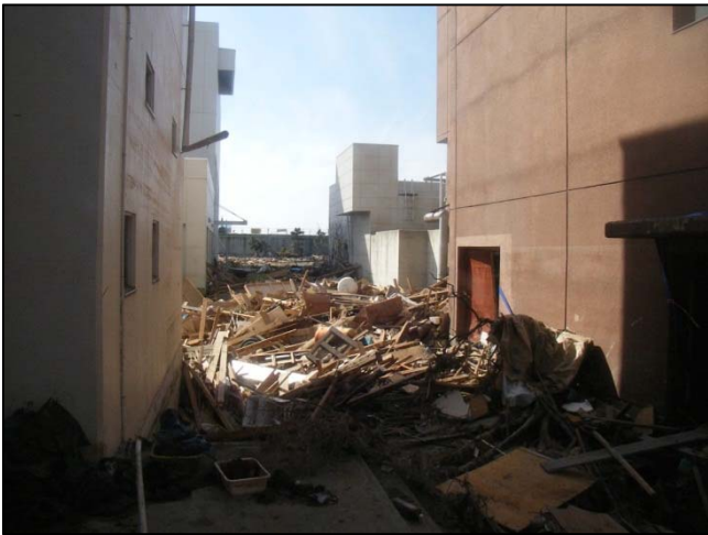
被災状況（H23.3.22撮影）
