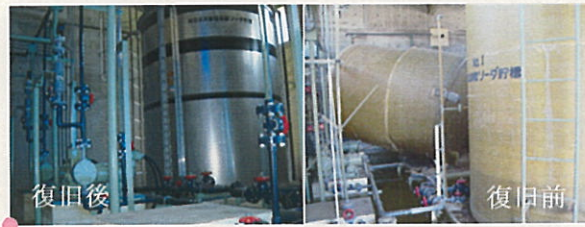
次亜塩注入設備の復旧
