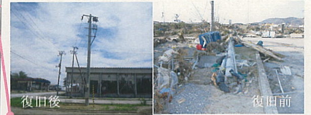
電力柱の復旧
