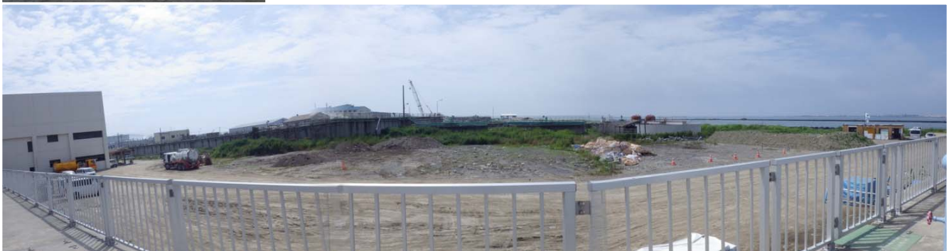
復旧状況（H24.7月：場内から瓦礫搬出完了）
