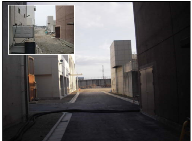
復旧状況（瓦礫撤去・舗装等）
