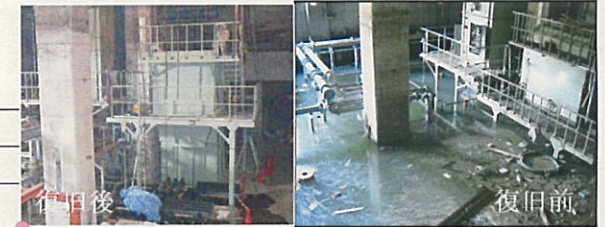
沈砂掻揚機の復旧
