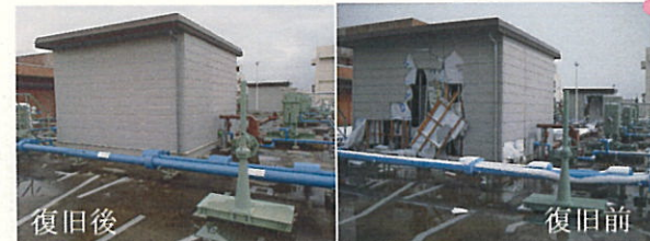
3系水処理水質計器室の復旧
