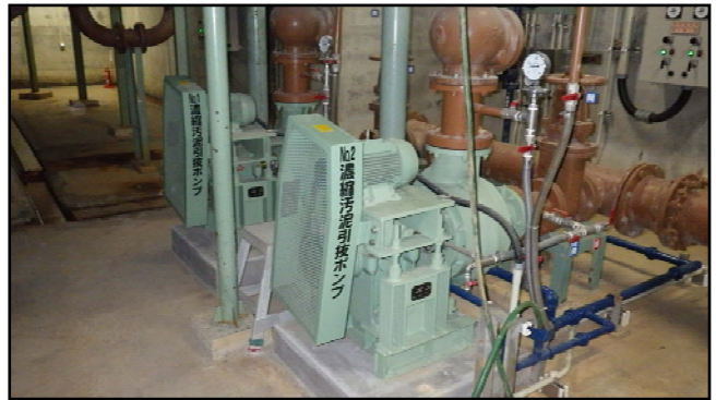
復旧状況（瓦礫撤去・汚泥引抜ポンプ・現場盤）
