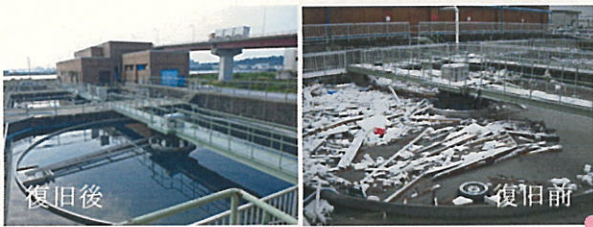
1系最終沈殿池の復旧
