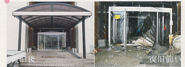
管理棟玄関の復旧
