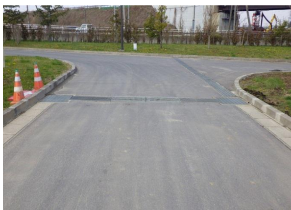
石巻浄化センター 場内舗装復旧後
