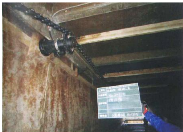
復旧後の最終沈殿池掻寄機
