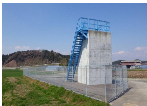
2-101 特殊人孔 舗装・フェンス復旧後
