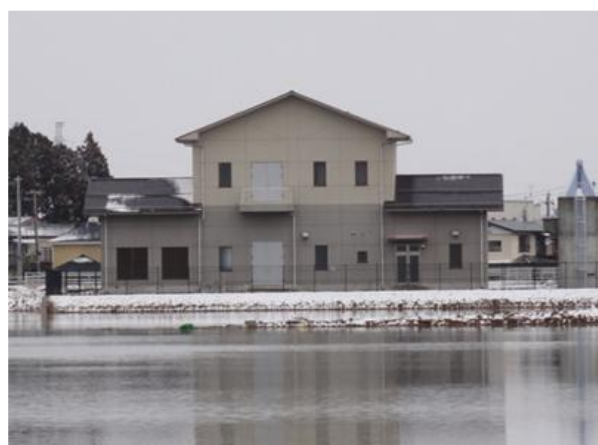
矢本ポンプ場被災状況
