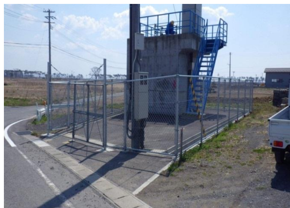
鳴瀬ポンプ場 舗装・フェンス復旧後
