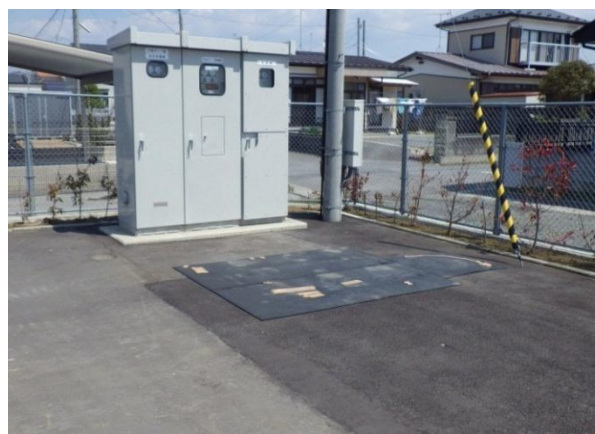
河南ポンプ場 段差復旧後
