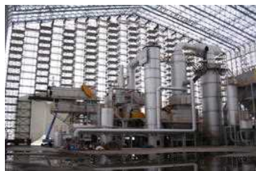
周辺に影響を与えないように焼却炉をテントで覆い、管理された密閉空間内で解体作業が行われました。
