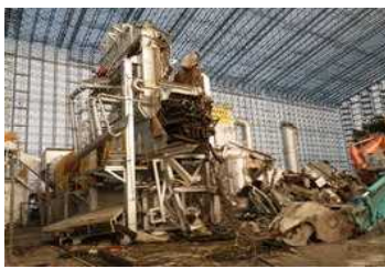
焼却炉解体の様子です。
