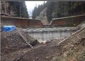
施工延長 L=41.0m<br>掘削工 A=1,370m <sup>2</sup><br>コンクリート工 V=534m <sup>3</sup>   |
