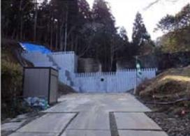
施工延長 L=23.5m<br>掘削工 A=500m <sup>2</sup><br>コンクリート工 V=1,065m <sup>3</sup>   |
