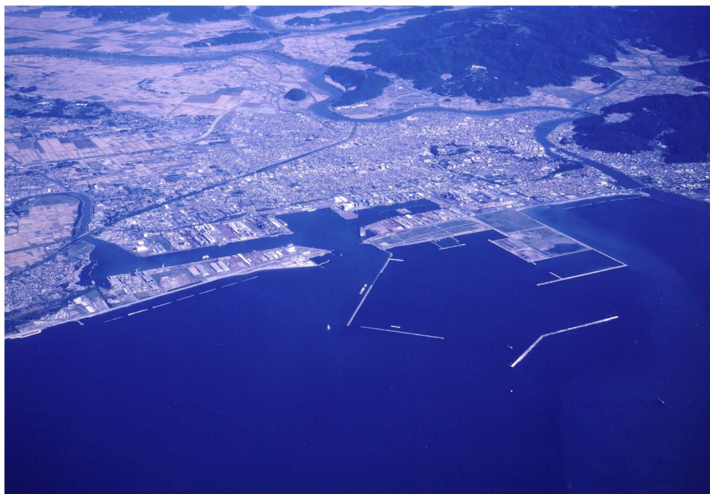
石巻港現況写真
