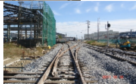
同じ箇所 の復旧後
