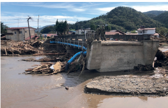
令和元年東日本台風で甚大な被害を受けた町内
