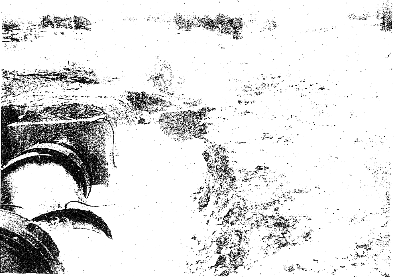
仁向 江塩広域水道 白石工区付近 伸縮管被管 \phi 2,400 mm
