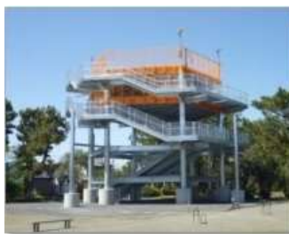
津波避難タワー
