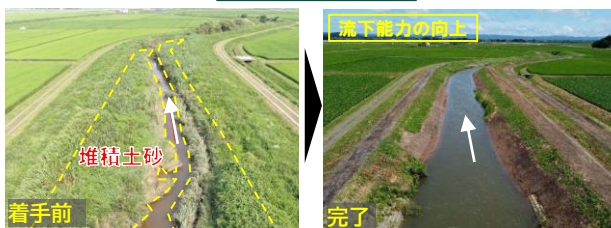
河道掘削(熊谷川)
