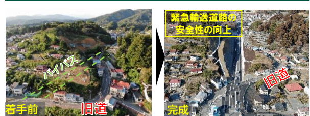
道路ネットワークの機能強化((主)気仙沼唐桑線 化粧坂地区)
