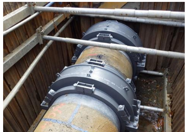
伸縮可撓管補強(鹿又川水管橋)
