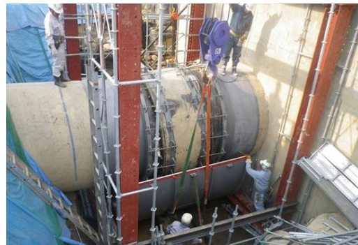
伸縮可撓管の補強状況
