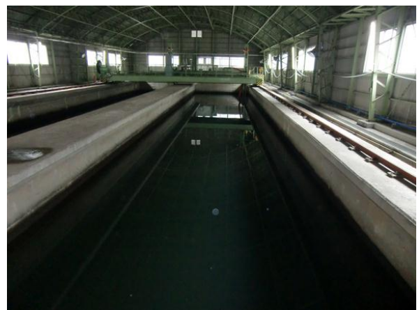
熊野堂沈砂池(耐震補強予定)
