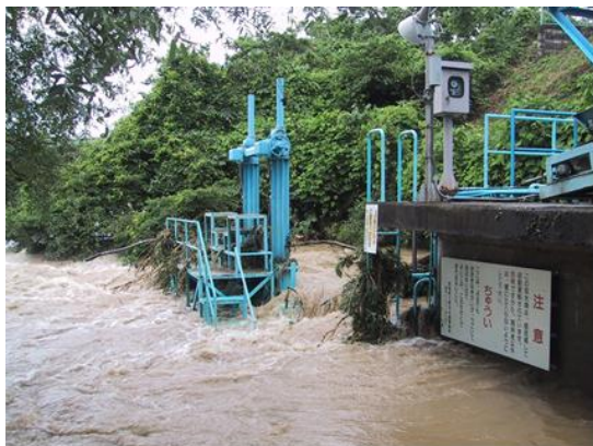
仙塩工業用水道 郷六取水場（広瀬川） 大雨による高濁度発生状況
