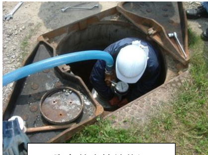
緊急給水接続状況
