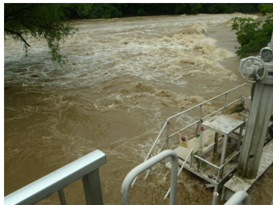
仙塩工業用水道 郷六取水場（広瀬川） 大雨による高濁度発生状況
