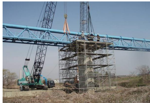
七北田川第2水管橋(復旧状況)
