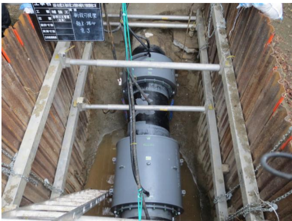
伸縮可撓管の補強状況
