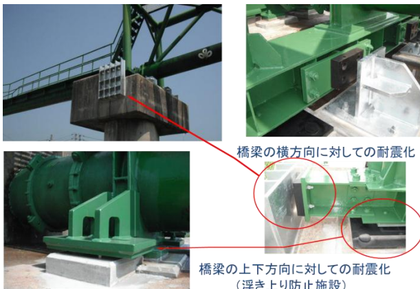
水管橋耐震補強例(大崎広水)
